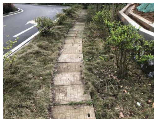
图 4 道路侧路基边沟
